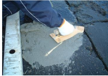
②水中施工の様子
