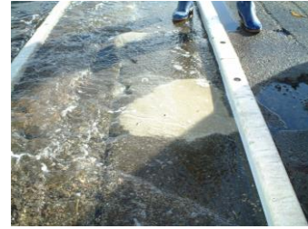
③施工完了
