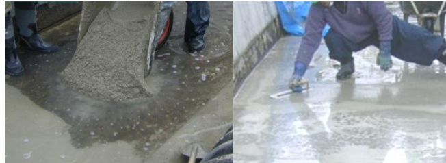
②水中施工の様子
