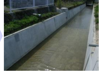
③施工完了
