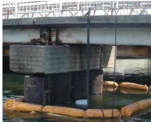
③水中グラウト注入
