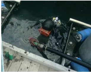
②潜水夫により設置作業
