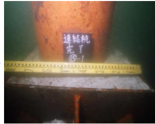
④施工完了
