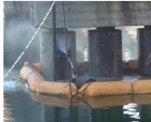
④施工完了
