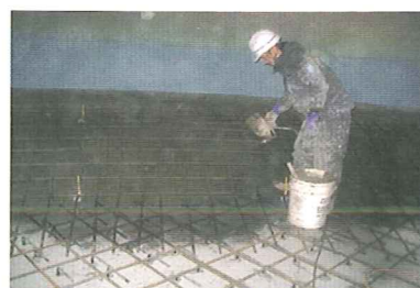
リシンガンによる吹付け 鉄筋を障害とせず施工
