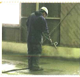
モルタルガンによる吹付け
