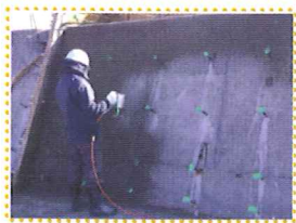
リシンガンによる吹付け
